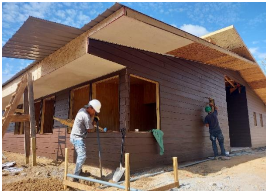
Avance de la nueva edificación.
