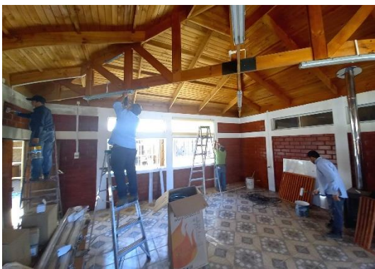
Habilitación de escuela provisoria.
