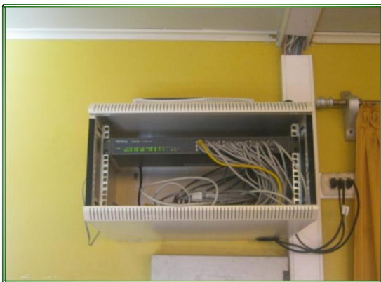
Instalación puntos de red Informática
