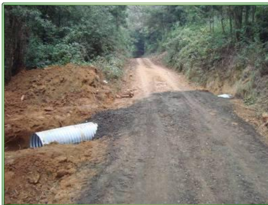
Cementerio Los Pantanos, Construcción de alcantarilla
