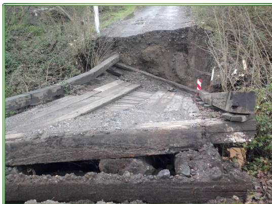
Taboleo Diuquín por el Águila, Puente Cea debilitado por terremoto y caído en temporal de Agosto 2010 y posterior fotografía de puente reconstruido
