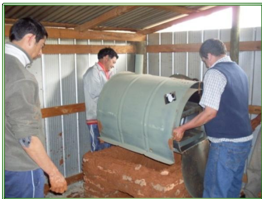
Construcción hornos, sector El Pino
