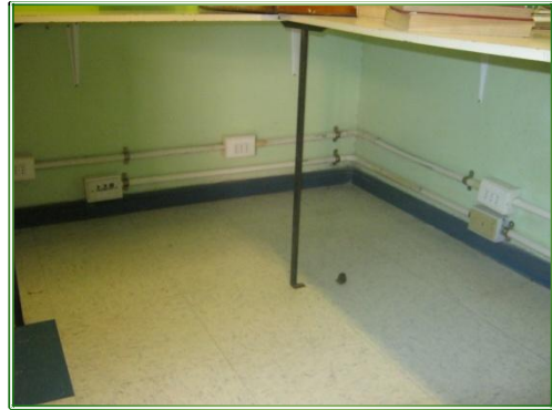
Canalización red Internado
