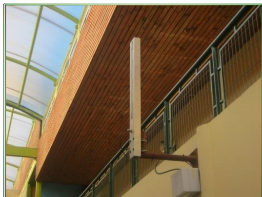
Instalación Antena Wi fi
