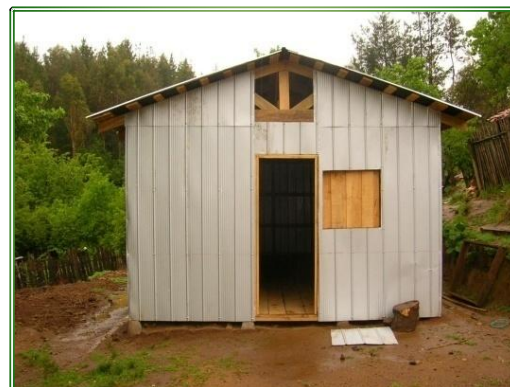
Bodega reconstruida con Bono INDAP
