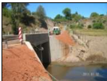
Inauguración Puente Palmilla
