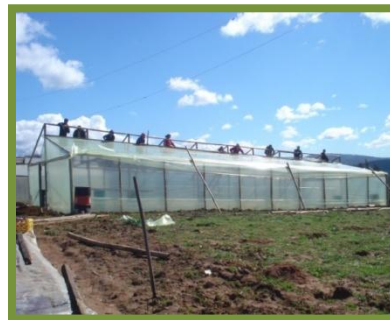
Construcción invernadero comercial
