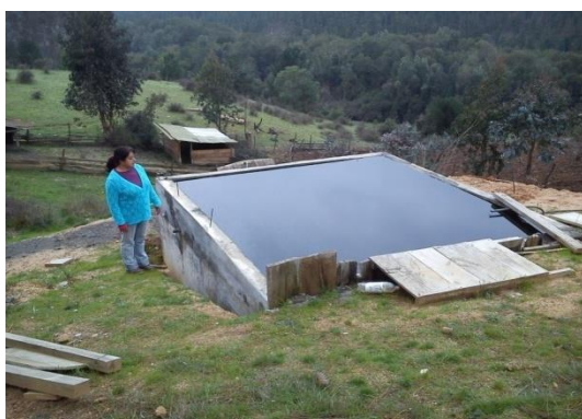
EJECUCIÓN DE PROYECTOS IFP “ESTANQUE ACUMULADOR DE AGUA” PARA RIEGO
