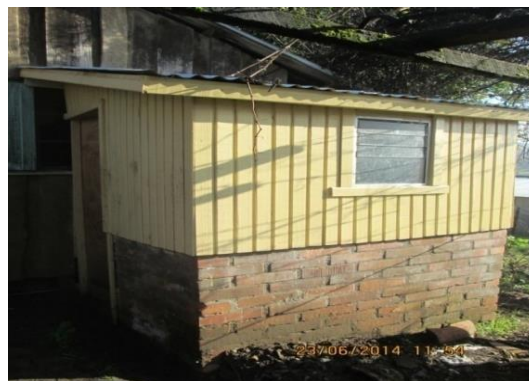
Construcción recinto baño.
