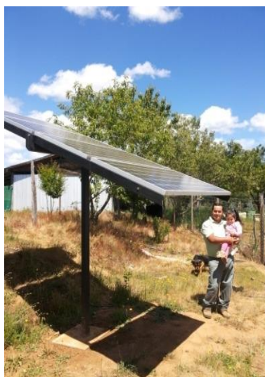
EJECUCIÓN PROYECTO IFP PANEL FOTOVOLTAICO PARA RIEGO Y VIVIENDA.
