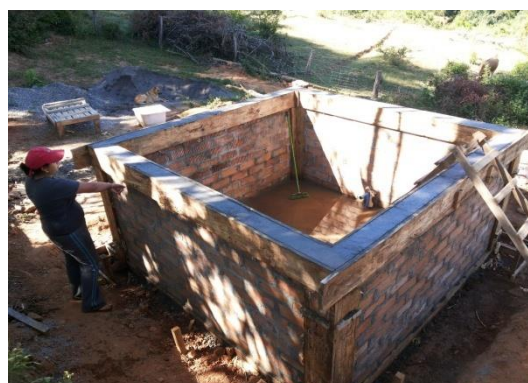
EJECUCIÓN DE PROYECTOS IFP “ESTANQUE ACUMULADOR DE AGUA” PARA RIEGO
