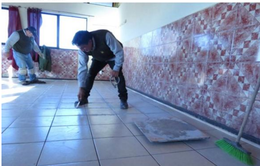
Instalación Cerámica Salas Liceo Municipal Fondo FAEP 2015
