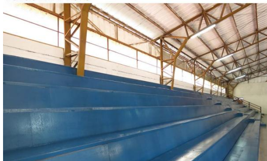
Renovación Galerías Gimnasio Municipal Fondo FAEP 2015
