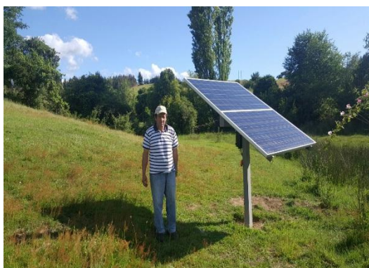
PROYECTO "PANEL FOTOVOLTAICO PARA RIEGO", JOSE ANSELMO CEA NAVARRETE, EL CARDAL
