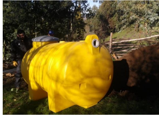
Instalación Fosa Séptica.
