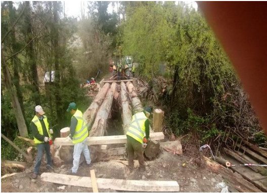
Puente Santa Luisa
