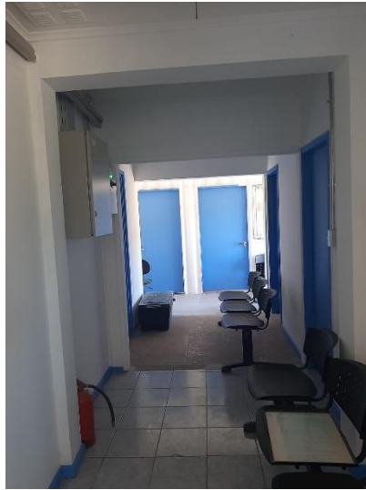
Cierre área contenedores Posta Choroico
