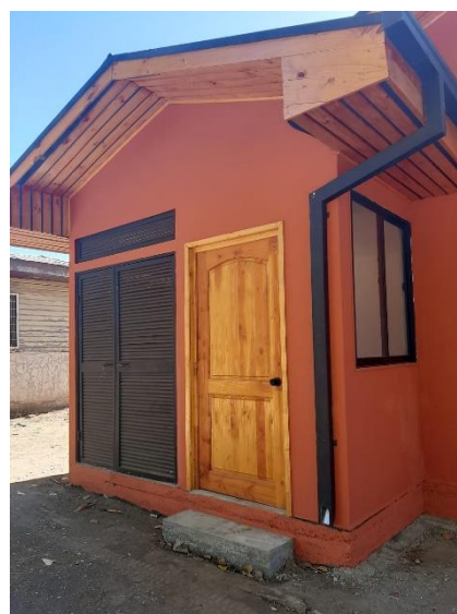
Cierre área contenedores Posta Choroico
