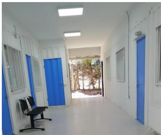
Mejoramiento techumbre y cierre contenedores Posta Culenco
