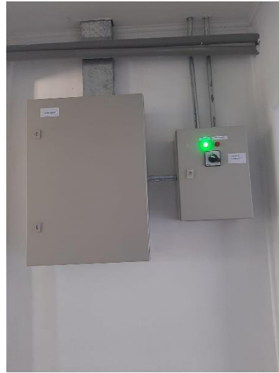
Mejoramiento sistema eléctrico Posta Choroico
