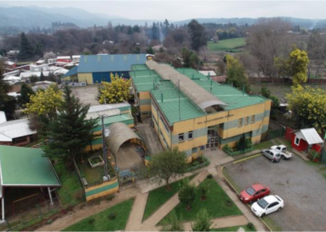
Edificio actual de la Escuela Óscar Guerrero Quinsac.
