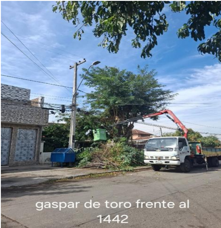
Ilustración 22. Imágenes de intervención de arbolado urbano realizados por empresa externa y equipo municipal.
