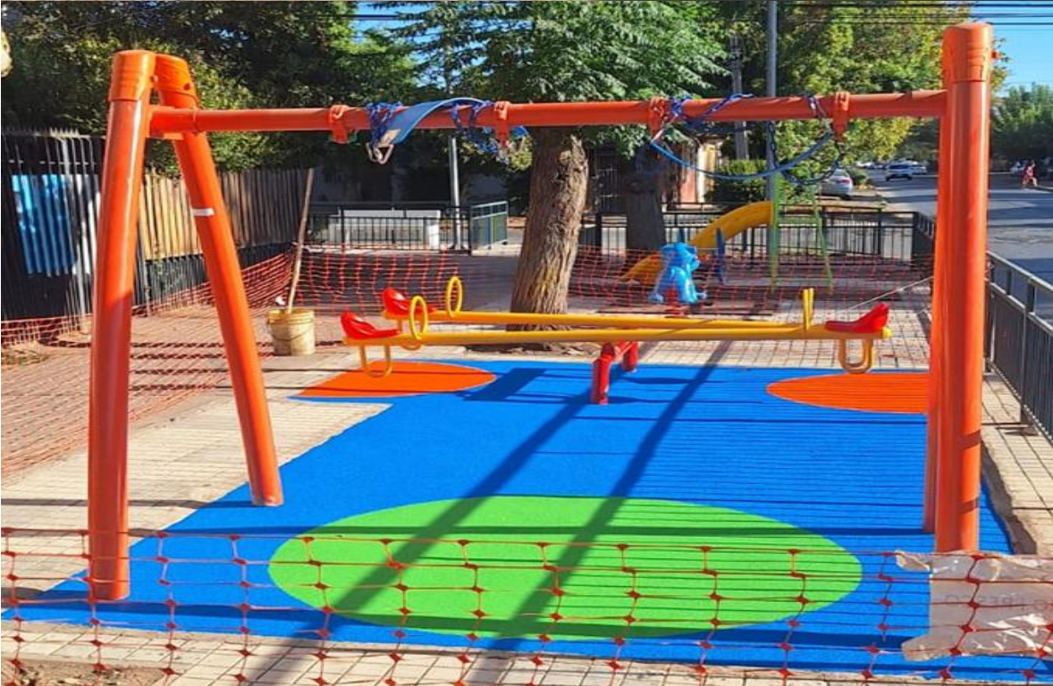
Ilustración 11. Instalación de juegos infantiles y piso de caucho in situ en Plaza Alsino.
