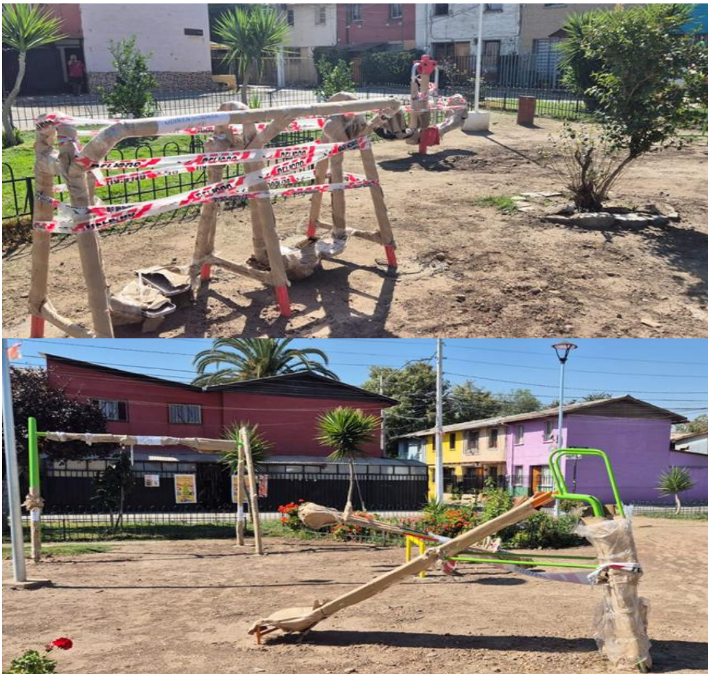
Ilustración 15. Instalación de nuevos juegos y equipos biosaludables en Plaza Pablo Sexto
